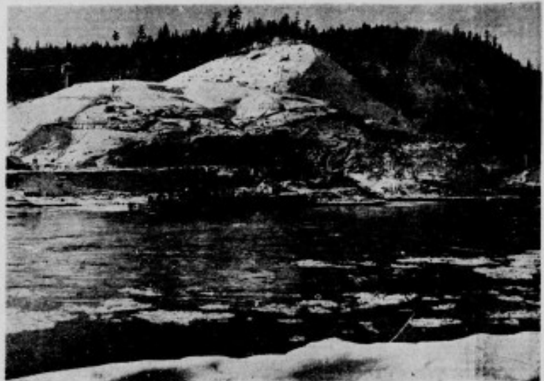
● Le canal de dérivation et le batardeau.
